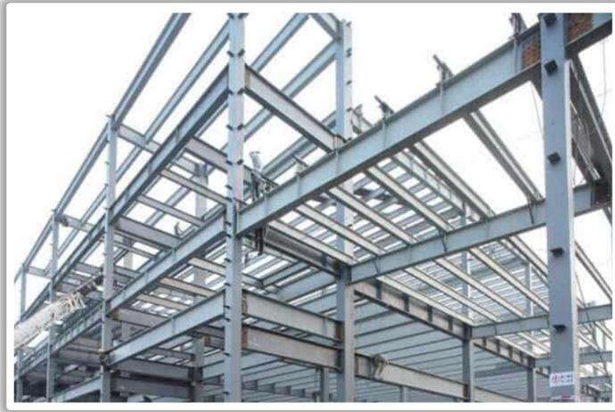
**Fabricación de Subensambles Estructurales en Viga IPR, Canal C, PTR, HSS, Perfiles, Etc. dejándolos listos para su entrega y así ensamblen en obra.**
